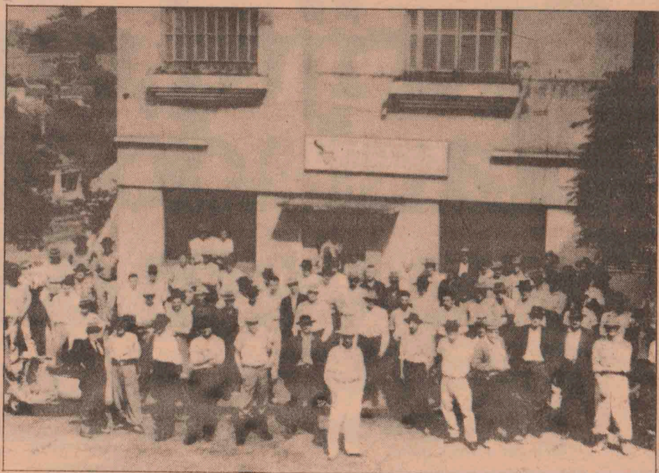
Neste prédio da rua Tiradentes (onde hoje está instalado o laboratório de análises clínicas Malmann) funcionou a primeira sede da Cotrijuí. Conta a história que neste dia, em 1958, não existia dinheiro para pagar o trigo.
