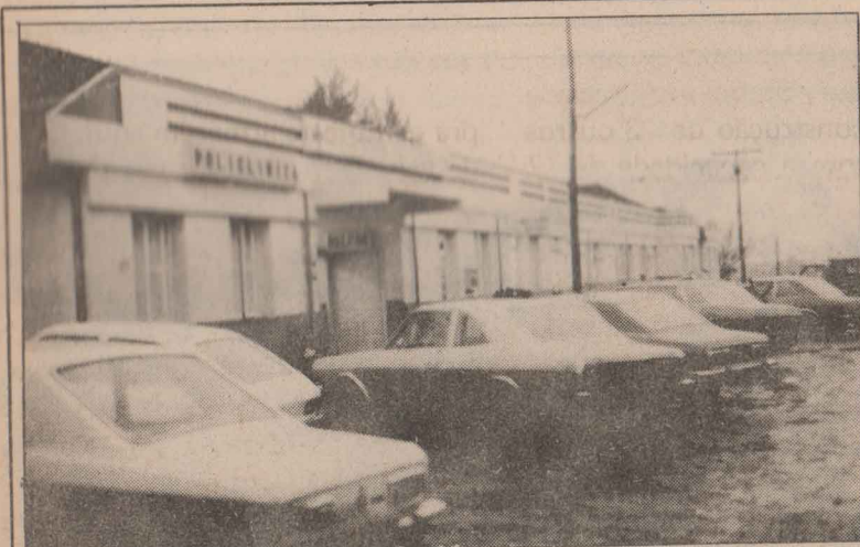
O prédio será remodelado
