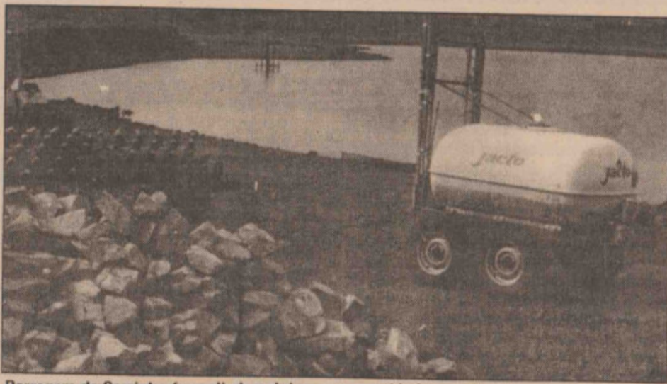
Barragem da Serrinha é ampliada e dobra sua capacidade
