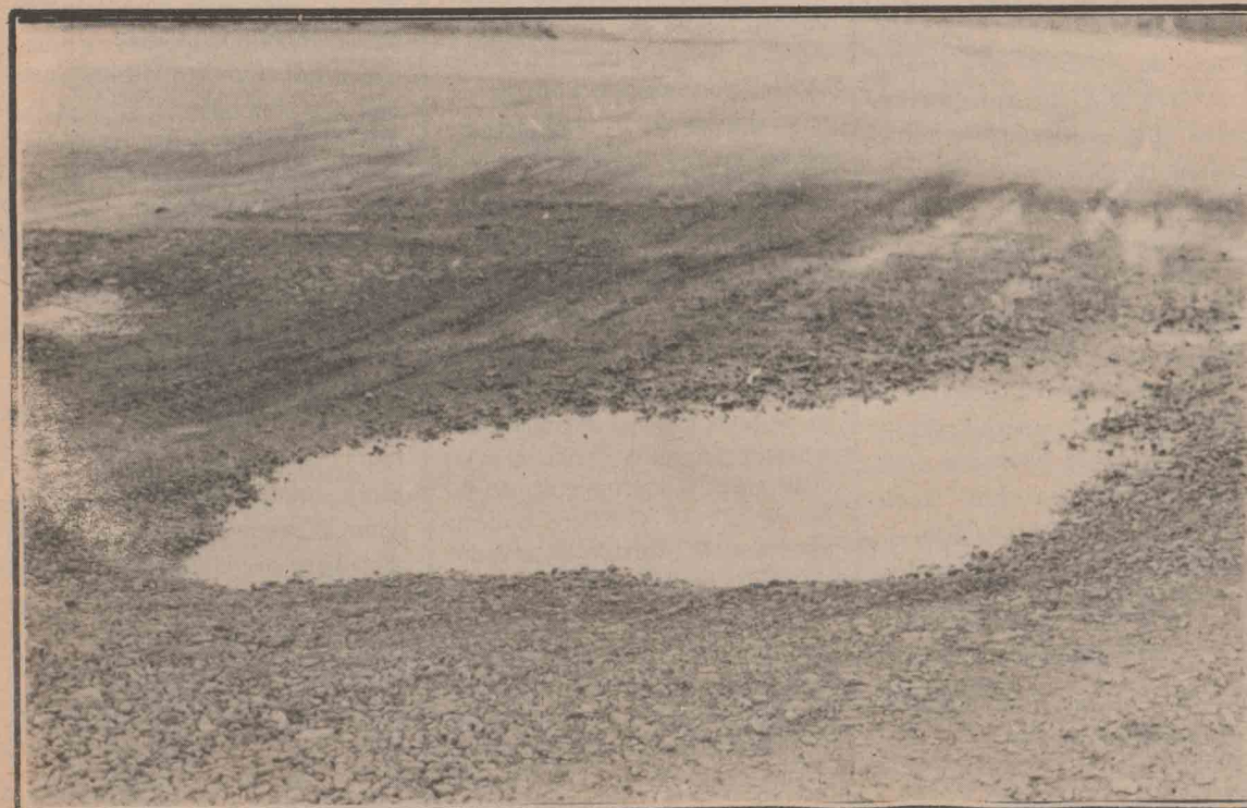
As rachaduras no asfalto aumentam até se transformarem em crateras.
