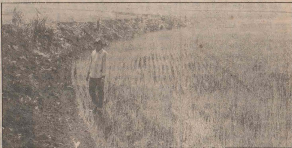
Os grandes terraços são construídos por tratores de esteira...
