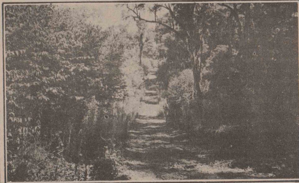
Estado atual da estrada, com o mato tomando conta do seu leito carroçável, pois a prefeitura está proibida de conservá-la.
